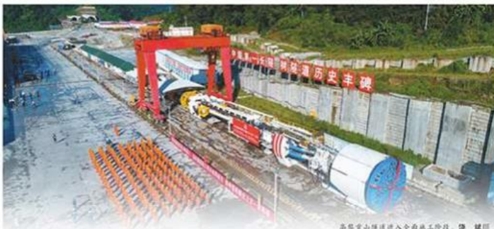
高黎贡山隧道进入全面施工阶段。 魏 斌 摄
